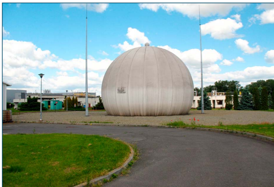
Fot. 2. Zbiornik magazynowy biogazu
